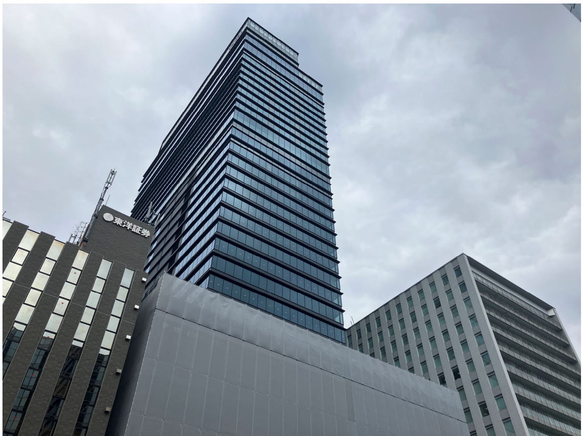
建設が進む地下1階付地上31階建の高層複合ビル「KAMIHACHI X（カミハチクロス）」 （広島市中区基町、2027年春竣工予定）
