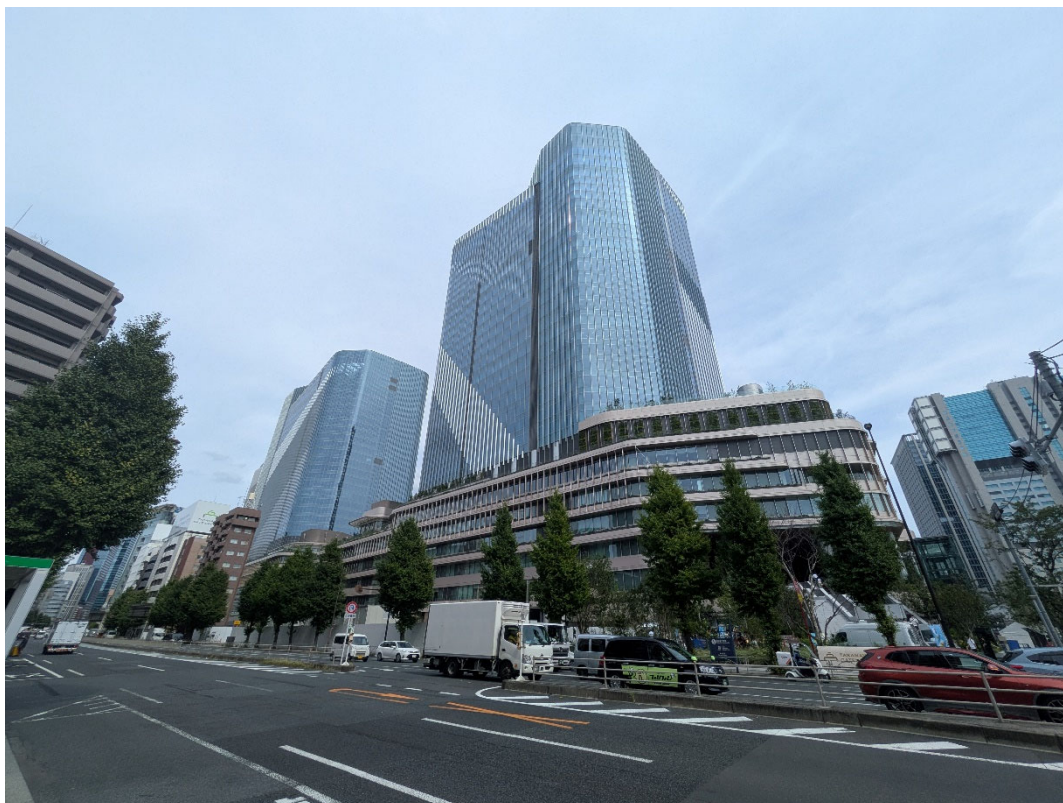
高輪ゲートウェイ駅前再開発ビル 「THE LINKPILLAR 1」
