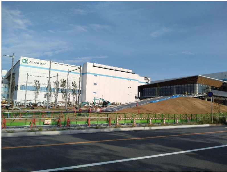
■10月竣工予定の「GLP ALFALINK 尼崎」北棟部分
