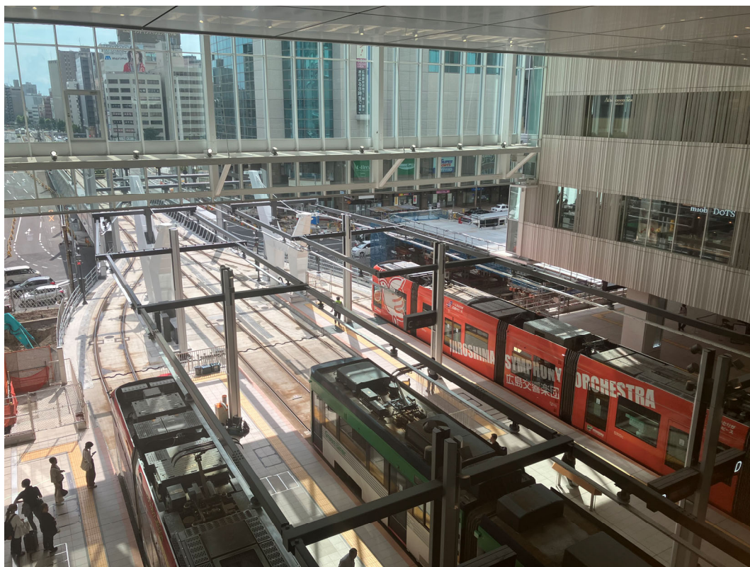
JR広島駅駅ビル「minamo」2階に高架で乗り入れる広島電鉄新路線 (駅前大橋ルート、2025年8月3日開業)
