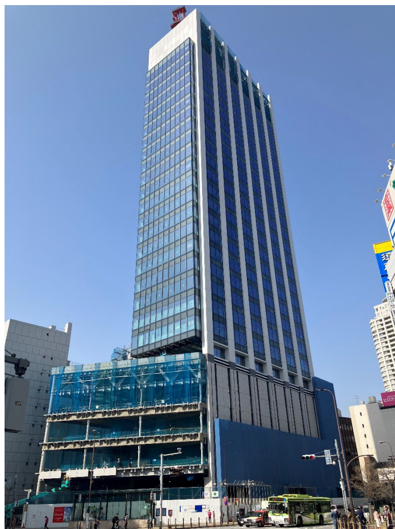
IT TOWER TOKYO (2025年11月竣工予定)
