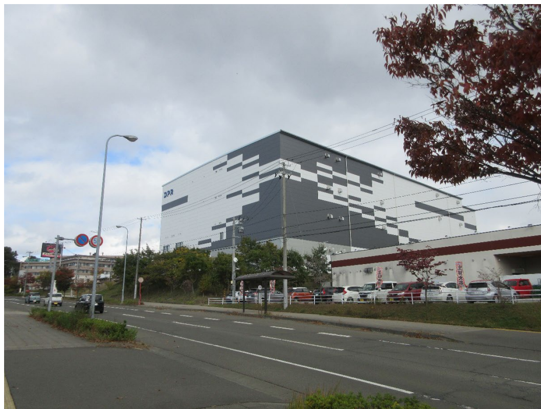
富谷市上桜木二丁目計画 (2024年10月竣工)
