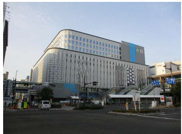
■建設中のヨドバシ仙台第一ビル （仙台駅東口至近）
