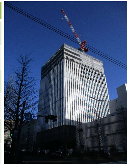
■アーバンネット仙台中央ビル (2023年11月竣工予定)
