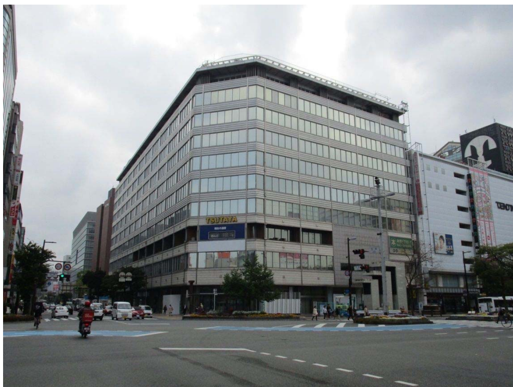
天神交差点 / 建替を控え閉館となった福岡ビル（通称：福ビル）
