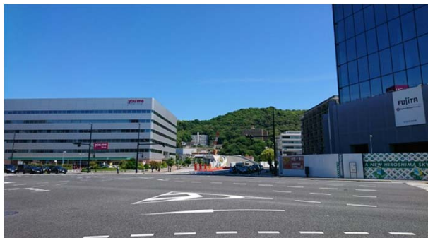
■広島高速5号線 駅北口から広島高速1号線の温品JCに接続する約4kmの有料道路。再来年度までの完成を目指す。
